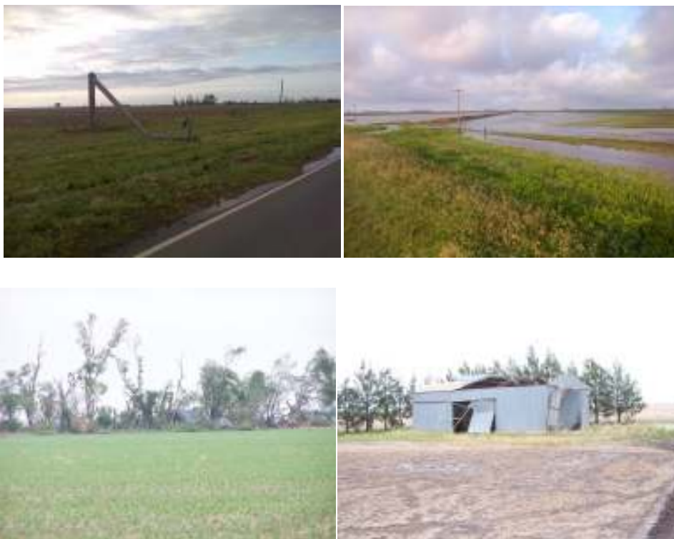
Daños registrados en la zona sur de Marcos Juárez a raíz de los fuertes vientos y anegamiento Fotos Ing Agr Juan Pablo Colomba.
